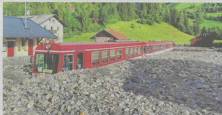
Dieses Bild kennen wir alle: Eine Mure verschüttete als Folge des Hochwassers 2021 eine Garnitur der Pinzgauer Lokalbahn zur Gänze. Foto: Pinzgauer Lokalbahn
