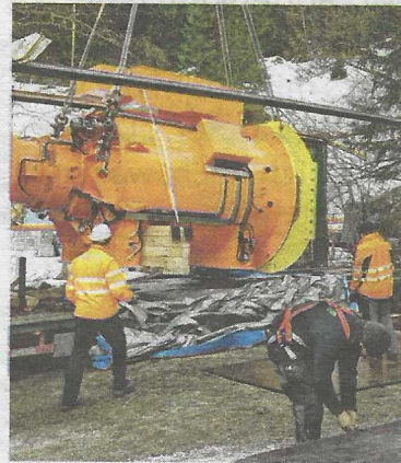
Kraftakt in Muhr im Lungau: Dieser 39 Tonnen schwere Generator fand an seinen Platz.
