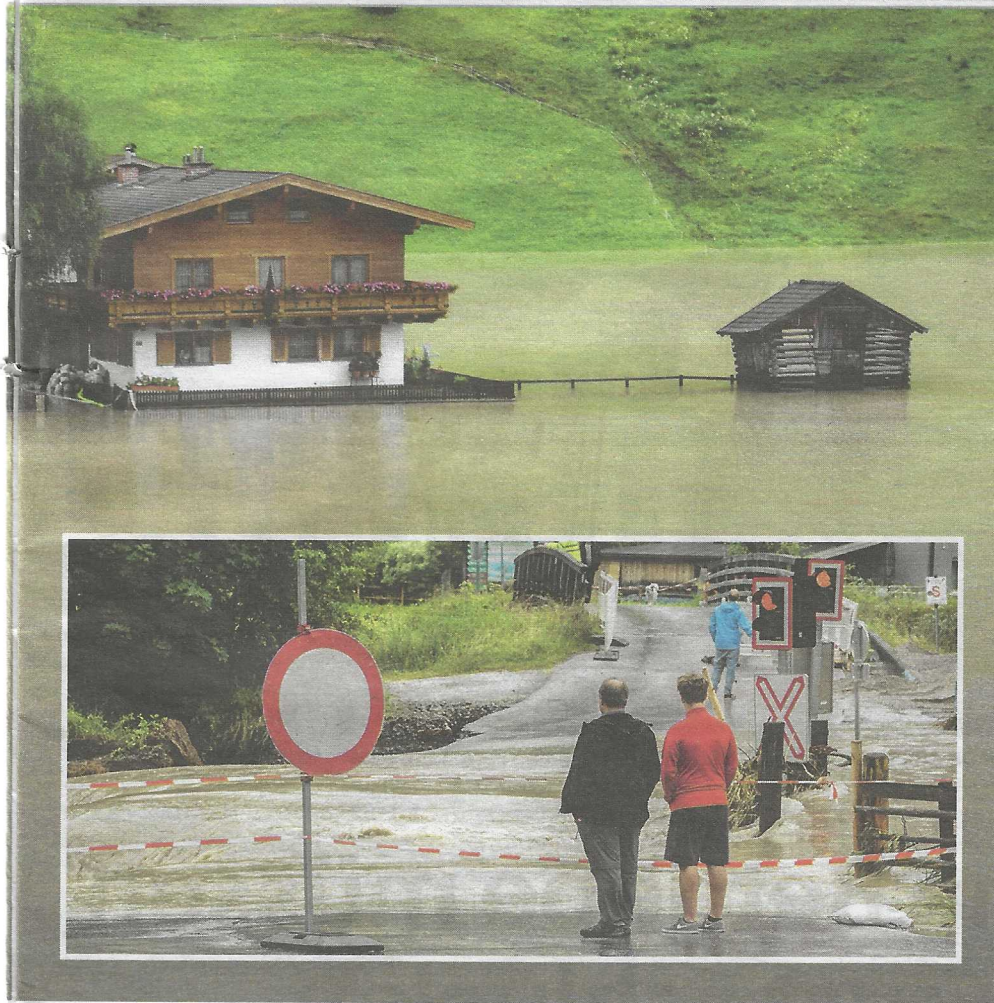
Die Schäden durch das Hochwasser sind groß. Aber ein katastrophales Ausmaß wie 2005 in Mittersill konnte der neue Hochwasserschutz noch verhindern.
