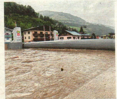
Die Hubbrücke wurde nicht aktiviert. Fotos (2): FF Mittersill/Fabian Scharler
