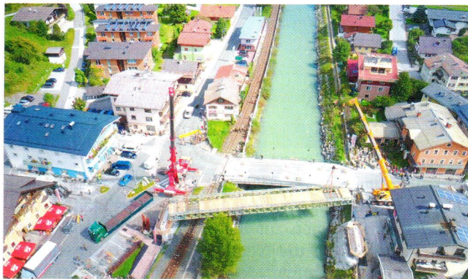
Die 28 Meter lange Hubbrücke wiegt 240 Tonnen. Derzeit erhält das Bauwerk mit der Montage der Pylonhüllen sein endgültiges Aussehen.
