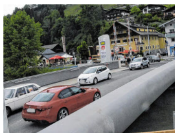
Neue Hubbrücke ist in Betrieb.
