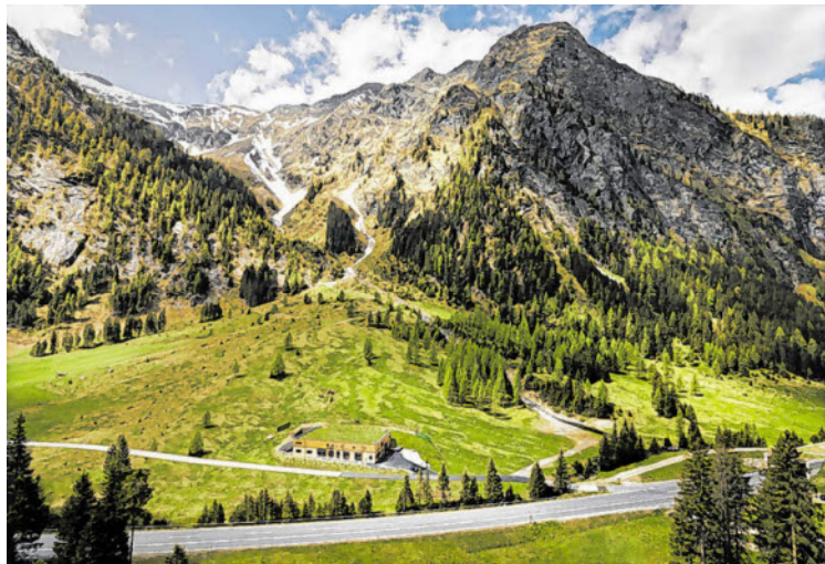
Das Ölkraftwerk liegt fünf Kilometer nördlich des Felbertauerntunnels auf der Taimeralm.
