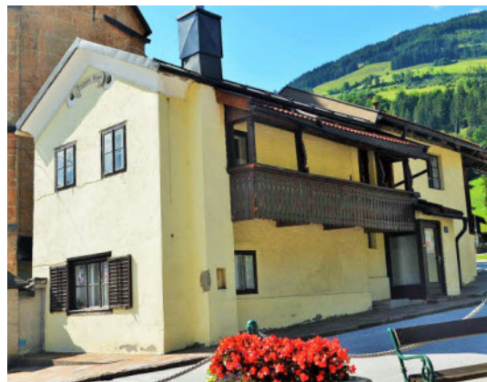
Das Neumaier-Häusl soll der zentrale Ort und Treffpunkt mit Kaffeehaus-Charakter sein.
