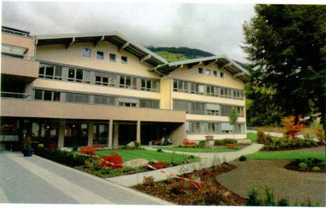
Im letzten Schritt erfolgte die Sanierung des bestehenden Objektes und die Errichtung der Gartenanlagen.
