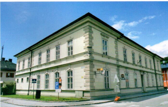
Die Sanierung der historischen Bausubstanz hat Priorität
