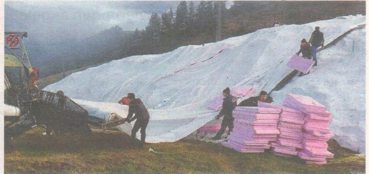
Das Schneedepot wurde von der Isolierung befreit und der Schnee in einer Schicht von 40 Zentimetern dann auf der 700 Meter langen und 60 Meter breiten Piste aufgebracht.
