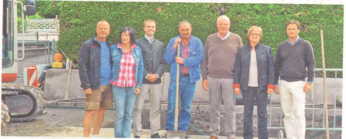
Setzen auf umweltfreundliche Wärme: Biowärme-Geschäftsführer Gerfried Walser (3.v.l.) mit zukünftigen Wohnungseigentümern und Vertretern der Baufirmen.
