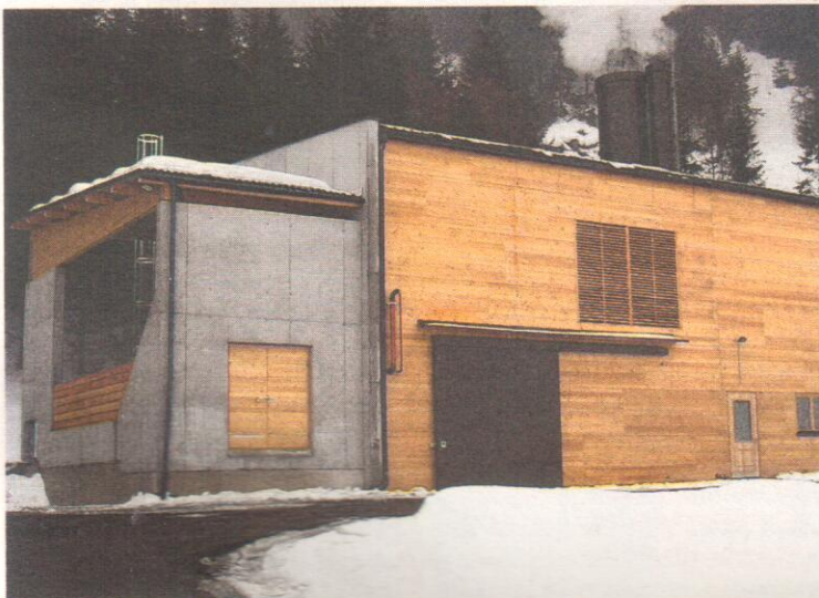
Seit Oktober 2005 ist das Heizwerk in Felben in Betrieb. Die Zukunft ist derzeit ungewiss. BILD: SWB/BRINEX
