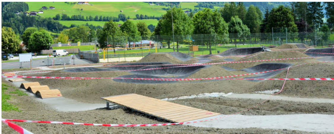
Noch ist abgesperrt: Restarbeiten wie die Bepflanzung stehen an.
