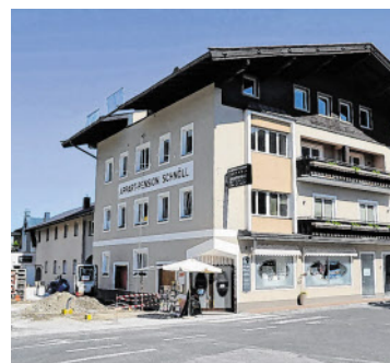
In den letzten Tagen wurde außen noch kräftig gearbeitet.
