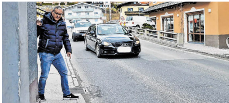
Nur rund 80 Zentimeter breit ist hier der Gehsteig – die Fahrzeuge kommen Fußgängern gefährlich nahe, sagt Bgm. Viertler. BILDER: SIMO
