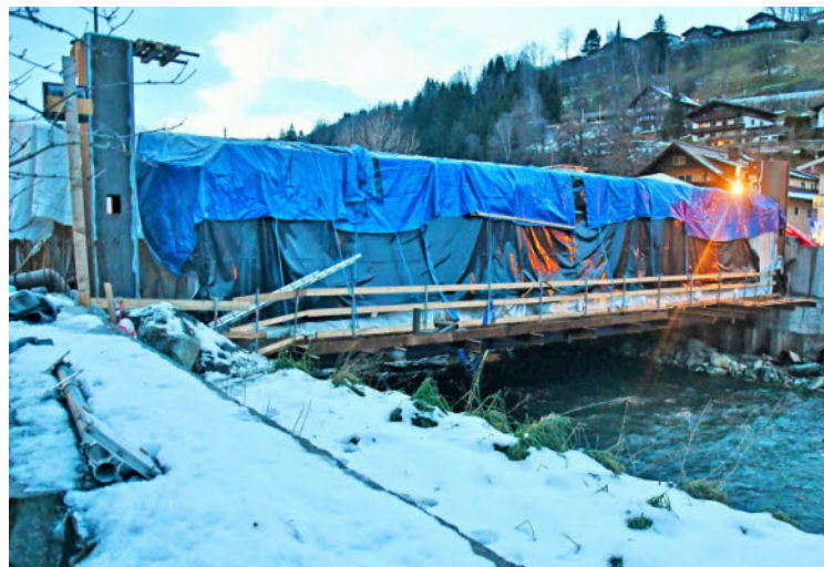
Um diverse wichtige Arbeiten vor der Witterung zu schützen ist die Hubbrücke derzeit eingehaust.
