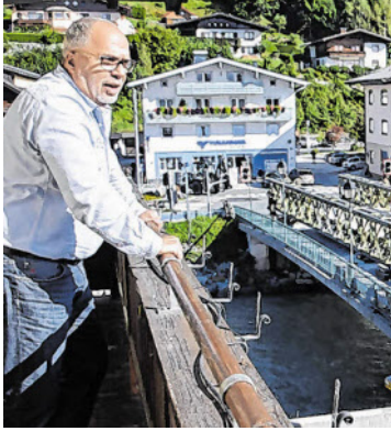
Anrainer Hans-Peter Maurer beobachtet die Arbeiten.
