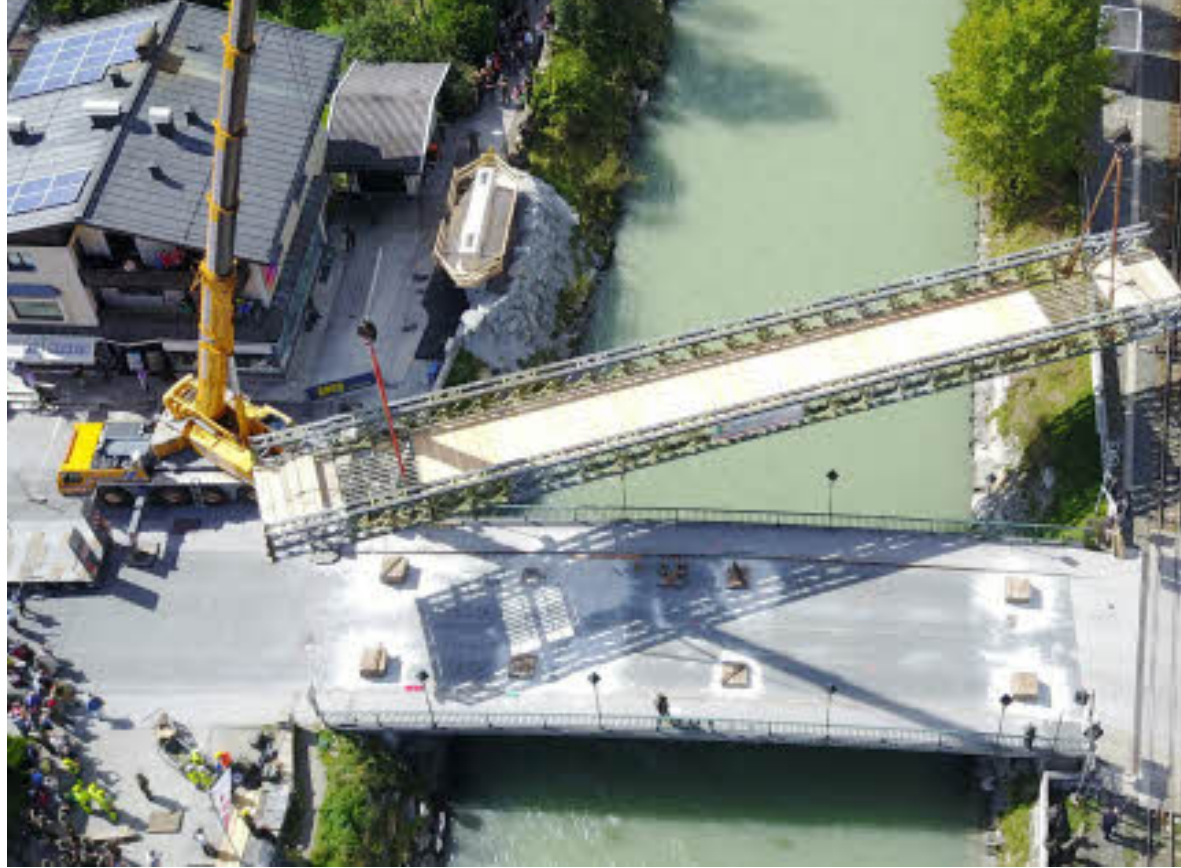
Die Fußgängerbrücke wurde auf der alten Brücke errichtet und danach mit zwei Kränen eingehoben.
