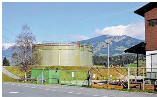
Der an der B165 liegende Tank wird komplett saniert. Es kann zu kurzzeitigen Beeinträchtigungen durch Ölgeruch, Staub und Lärm kommen. BILD: STADTGEM. MITTERSILL
