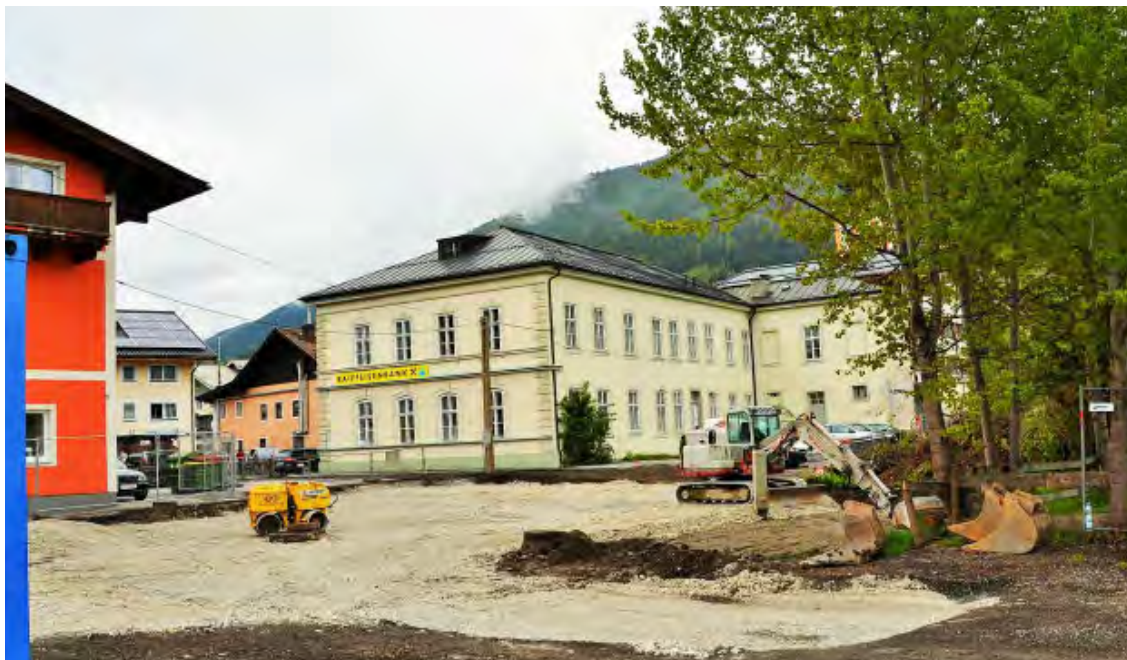
Die ehemaligen „Reinartz-Grundstücke“ (hinter der Tauern-Apotheke) werden als Parkfläche aufbereitet, und dort wird – während der Baustellenphase auf der Gerlos Straße im Zentrum – eine Ersatzstraße die Zufahrt in die Kirchgasse ermöglichen.
