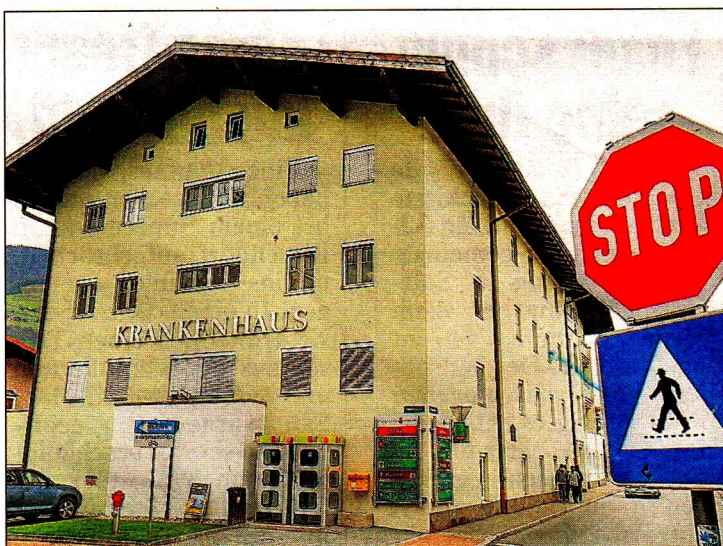
Für die neuen OP-Säle wurde das „Stopp-Signal“ jetzt aufgehoben
