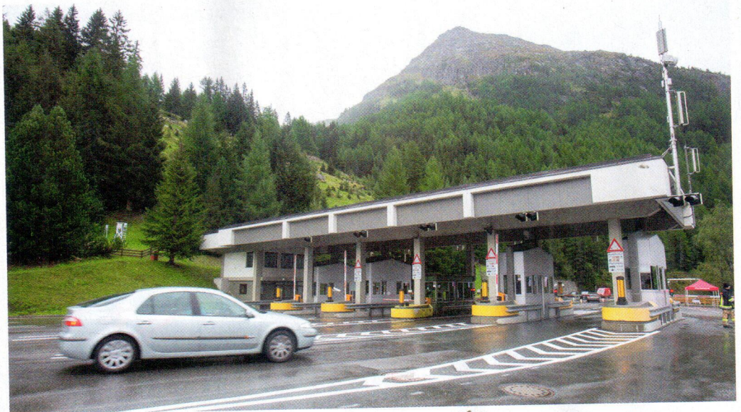
Seit 18. August ist die Felbertauernstraße wieder ohne Ampelregelung ungehindert befahrbar.
