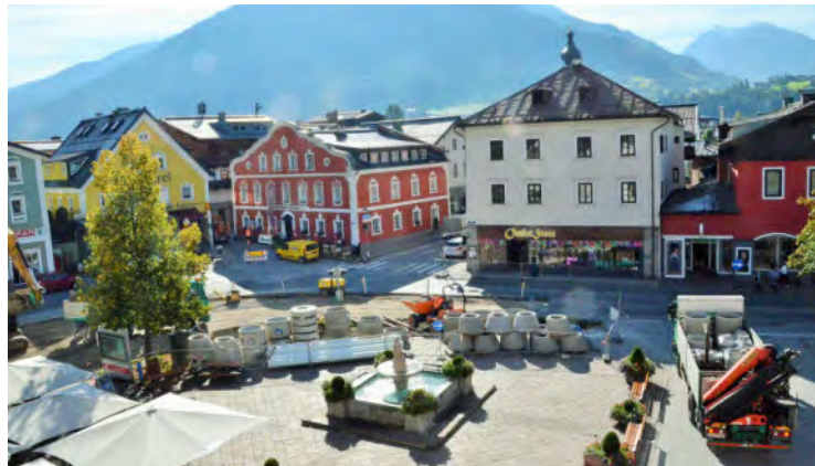
Die Bauarbeiten sind seit drei Wochen im vollen Gang, das Zentrum aber aus allen Richtungen gut erreichbar.
