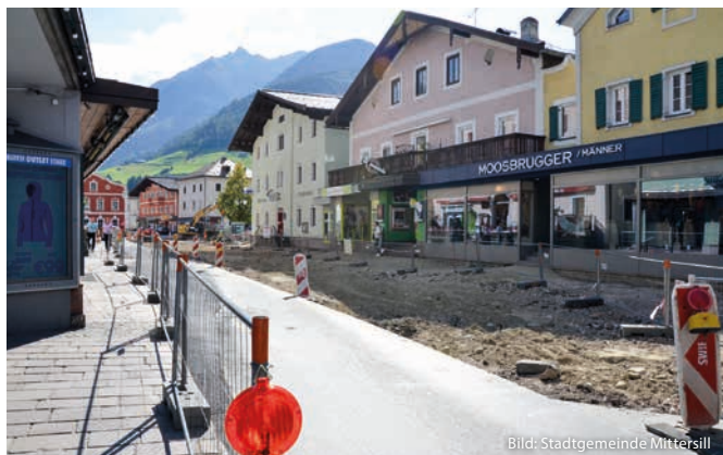
Baustelle 26. September 2016, 14:00 Uhr
