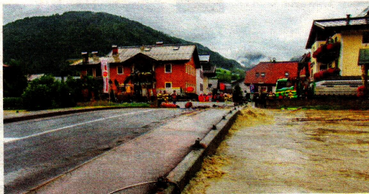
Die bestehende Brücke staut das Wasser auf.
