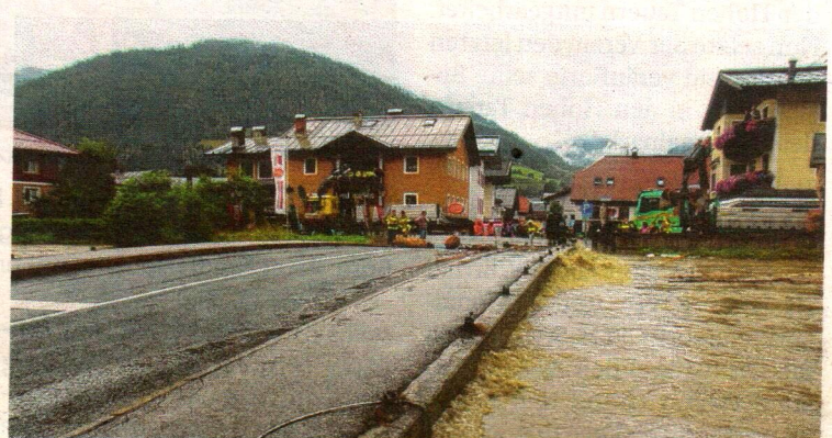
2014: Die tief liegende Salzachbrücke staut das Wasser auf.
