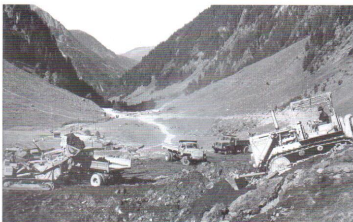
Der Bau der Felbertauernstraße
