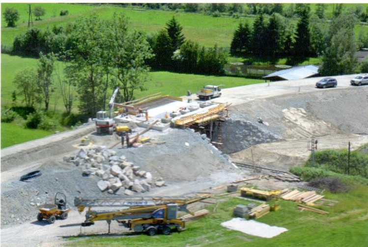
Ein wesentliches Element der Aufschließung: der deutlich verbesserte Bahnübergang in der Essiger Allee. (Bild: Stadtgemeinde Mittersill)
