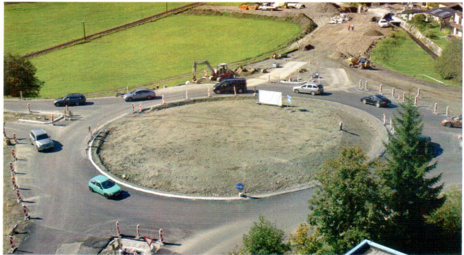
Die Bauarbeiten am neuen Kreisverkehr schreiten planmäßig voran
