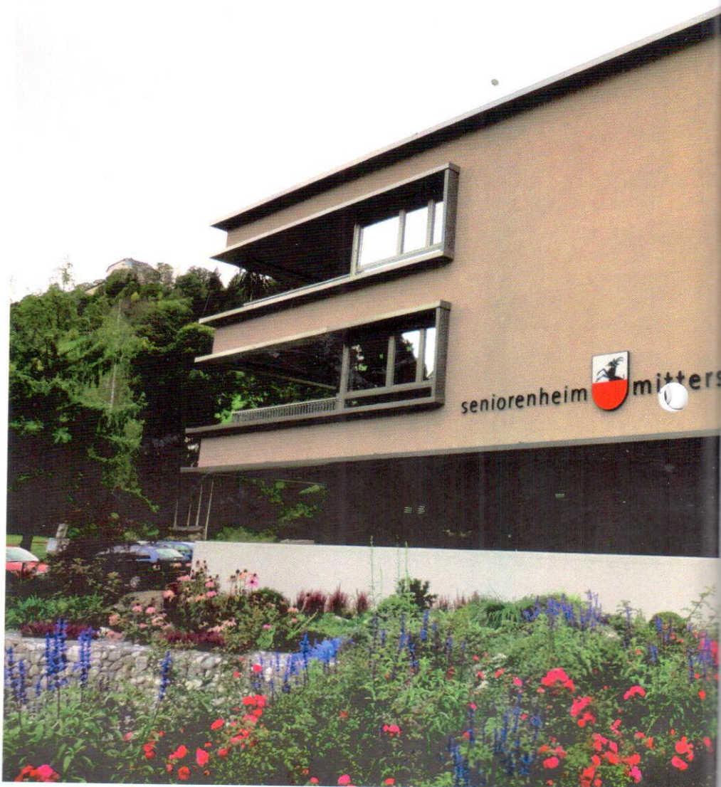
Ein zeitgemäßer Bau für die Senioren und Pflegebedürftigen; mit dem Neubau des Seniorenheimes ist eine ideale Altersversorgung
