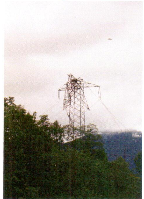
zerstörter 380 kV-Mast im Felbertal (Bild: Feuerwehr Mittersill)
