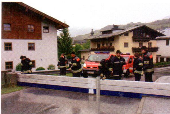
Aufbau der mobilen Schutzwände beim Felberbach (Bild: FF Mittersill)
