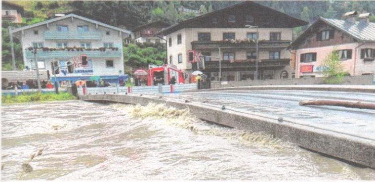
Verdammt knapp: Hochwasser bei der Salzachbrücke in Mittersill. Sie ist die größte Schwachstelle im Hochwasserschutz in Mittersill. Eine Neuplanung ist im Gange.
