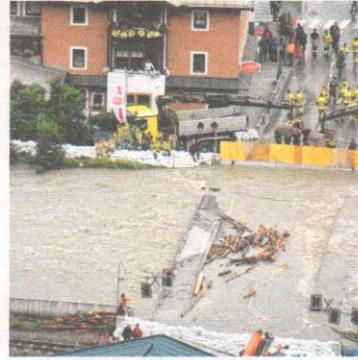
Verdammt knapp: Hochwasser bei der Salzachbrücke in Mittersill. Sie ist die größte Schwachstelle im Hochwasserschutz in Mittersill. Eine Neuplanung ist im Gange.
