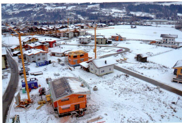
Zwei Kräne zeugen von einer regen Bautätigkeit, während andere Familien bereits im Eigenheim eingezogen sind. (Bild: Stadtgemeinde Mittersill)
