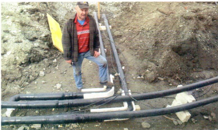
Heizwart Hans Mittermaier bei den Grabungsarbeiten im Ortsteil Felben im Bereich des „Baulandsicherungsmodells“. (Bilder: BW Mittersill)
