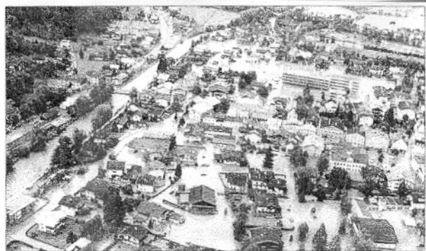
Mittersill braucht rasch einen Hochwasserschutz. Mit den vom Dammbau betroffenen Grundeigentümern soll bis Weihnachten über Entschädigungen verhandelt werden.
