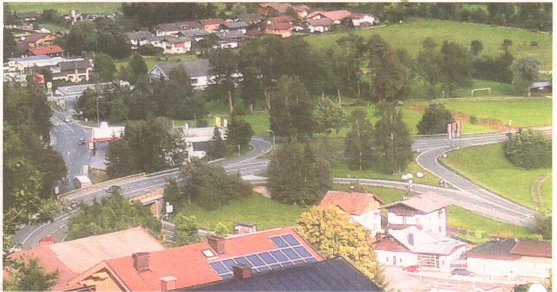
Verkehrsknoten in Mittersill-Burk. Dort wird jetzt ein Kreisverkehr gebaut.
