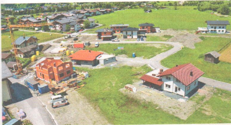
In Felben wird eifrig gebaut.
