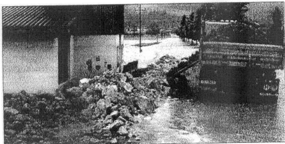
Ein Umspannwerk in Bramberg konnte im letzten Moment mit einem provisorischen Damm vor der Überflutung bewahrt werden. Bild: SN/ANTON KAINDL
