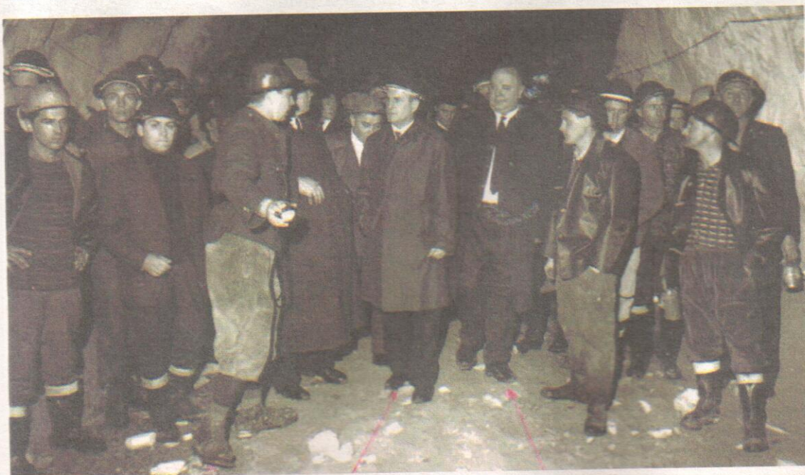
Der Tunneldurchschlag am 11. April 1964. Der wichtigste Bauabschnitt war geschafft. Bild: SW/REPRO MUSEUMSVEREIN
