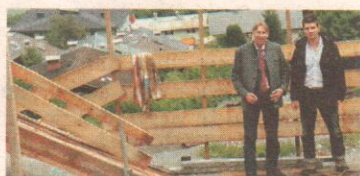
Sicherungsbauten in Zell am See. Bild: Simonitsch
