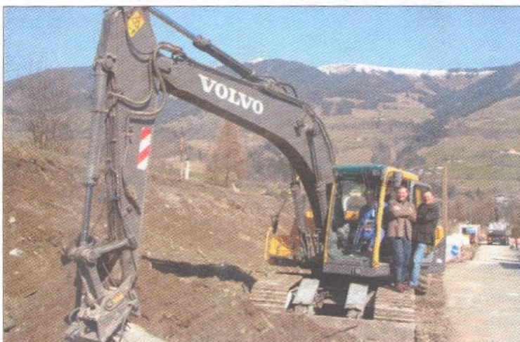
Baustellenbesichtigung in Felben durch Bgm. Wolfgang Viertler und Vize-Bgm. Roman Oberlechner.
