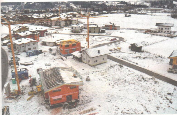
Fleißig gebaut wird im Ortsteil Felben, wo von der Stadtgemeinde günstiges Bauland gesichert werden konnte. Bild: SW/GEMEINDE MITTERSILL
