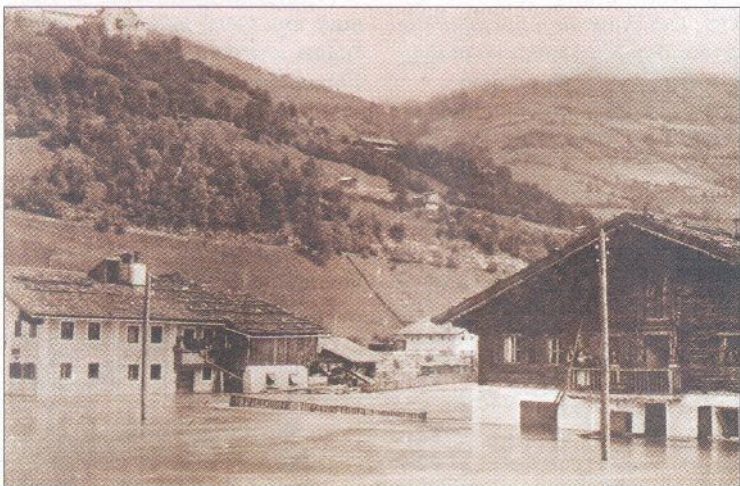
Ebenfalls im Jahr 1903: Überflutungen im Bereich Tischlerhaus (Schnöll)
