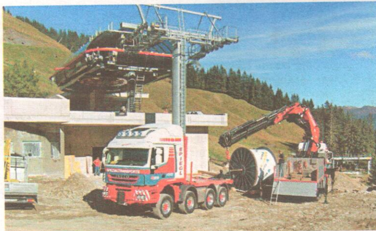
Zügig und plangemäß schreitet der Bau voran.
