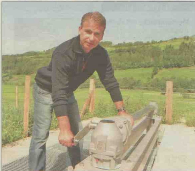
Feuerwehrchef Georg Scharler an der Kurbel, mit der bei Hochwasser die Schleuse des Schutzdamms geschlossen wird.
