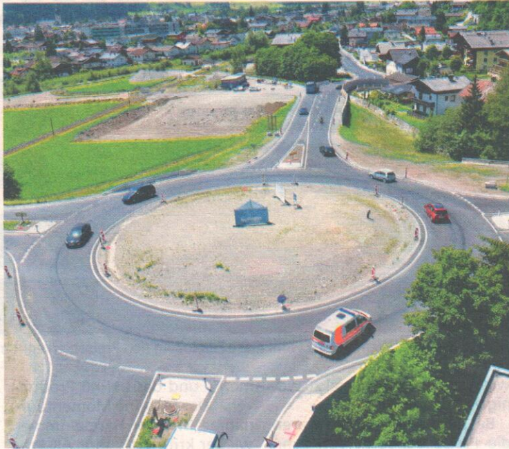
Im neuen Kreisverkehr treffen die Mittersiller Straße B168, die Pass-Thurn-Straße B161 und die Felbertauernstraße aufeinander. Bild: SN/PRIVAT
