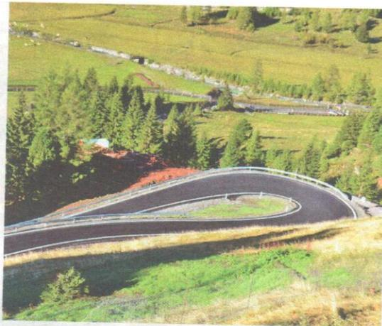
**Ersatzstraße** – sie ist 1,5 km lang und geprägt durch drei Kehren. Für den Winterbetrieb wurde eine griffige Asphaltsschicht aufgebracht.
