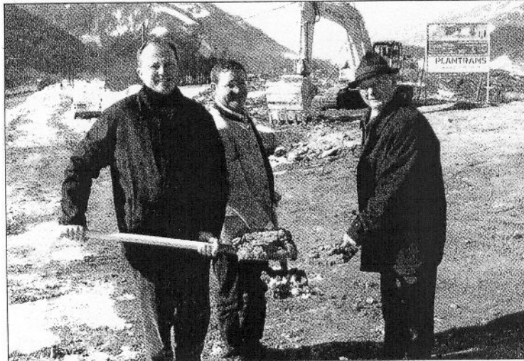
„Ein historisches Moment“: LR Sepp Eisl, Bgm. Wolfgang Viertler und der Leiter der Wasserwirtschaftsabteilung, Franz Hohensinn, beim Spatenstich. Bilder (2): SW/BRINEK
